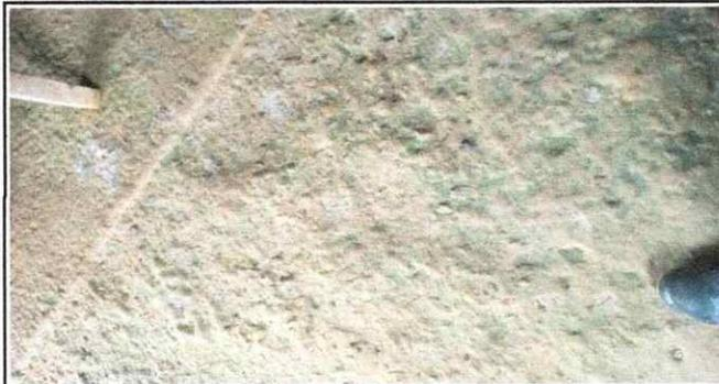
Foto 3: Falta de piso de concreto
