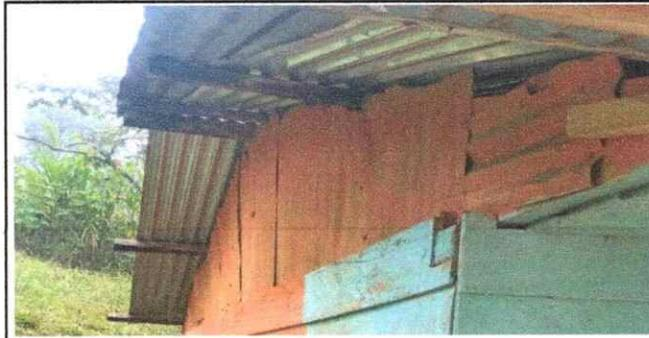
Foto 6: Se observa las costaneras de las aulas en mal estado.
