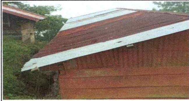
Foto 4: Se observan los capotes del techo en estado deteriorado
